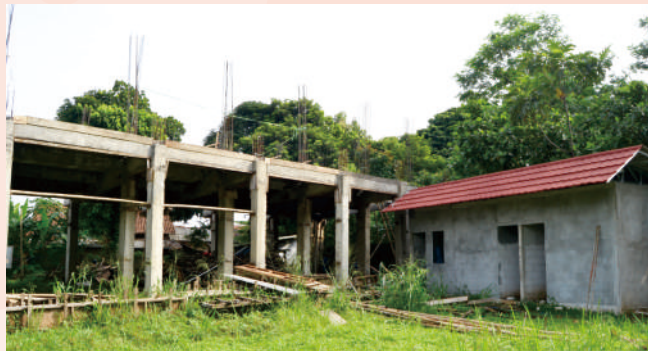
Progres Pembangunan Gedung Sekolah Gratis
